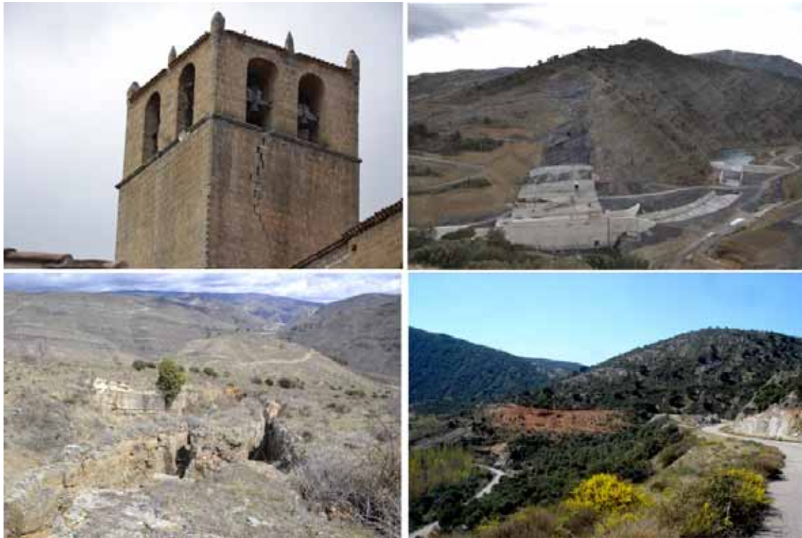
Figura 2. a. Grietas en la torre de Santa María de la Estrella, probablemente relacionadas con sismicidad. b. Orientación de los estratos del Cretácico inferior hacia el norte (izquierda) en la cerrada de la presa de Enciso. c) Grietas debidas a grandes deslizamientos aguas abajo de la presa. d) Una de las zonas problemáticas en el vaso del embalse.
