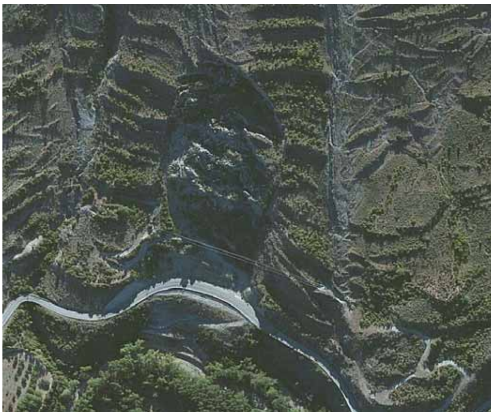
Figura 4. Deslizamiento rotacional con forma en cuchara aguas abajo de la presa de Terroba
