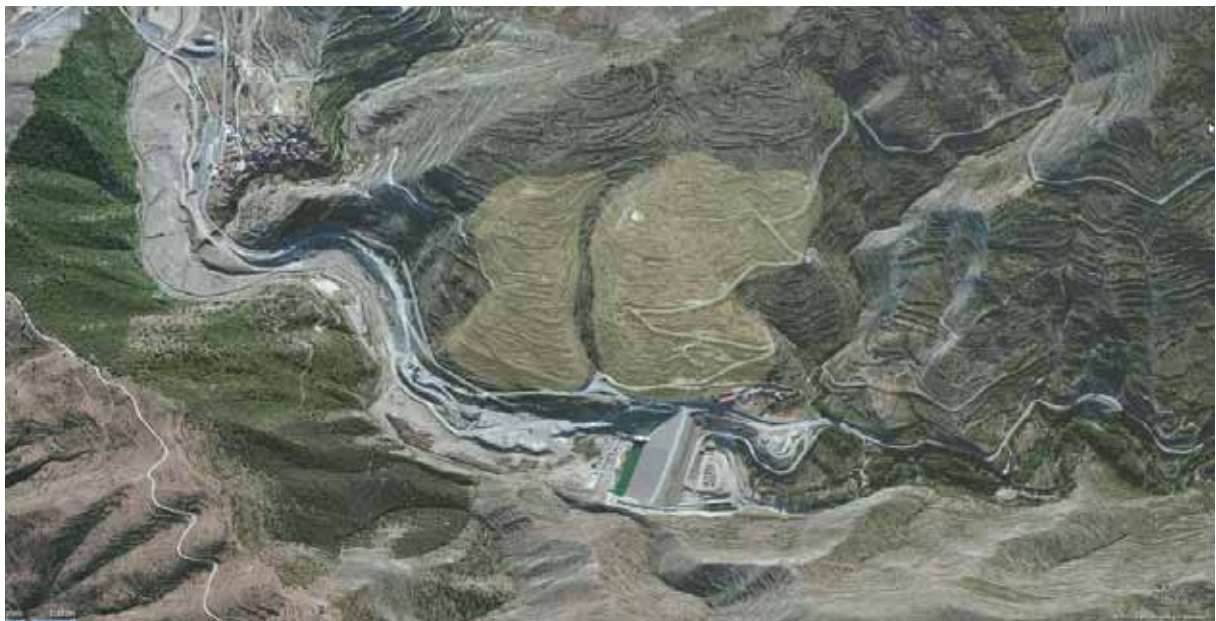
Figura 6. Vista oblicua de las dos grandes masas deslizables en la margen izquierda del Leza, que comportan un alto riesgo tanto para el vaso como para la presa de Terroba.
