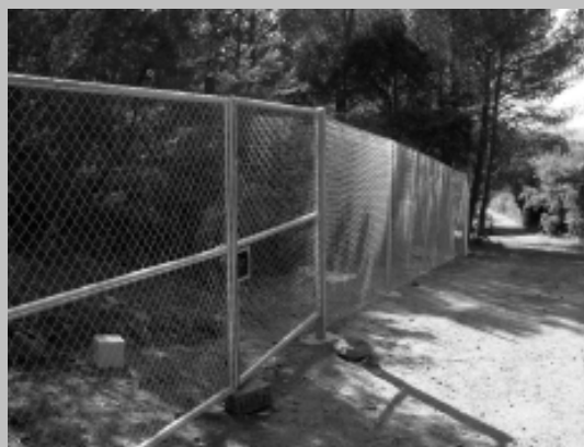
Imagen 5: Instalación de cerca en espacio menos consolidado
