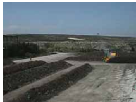
Planta de compostaje de la Mancomunidad de Montejurra (Navarra)
