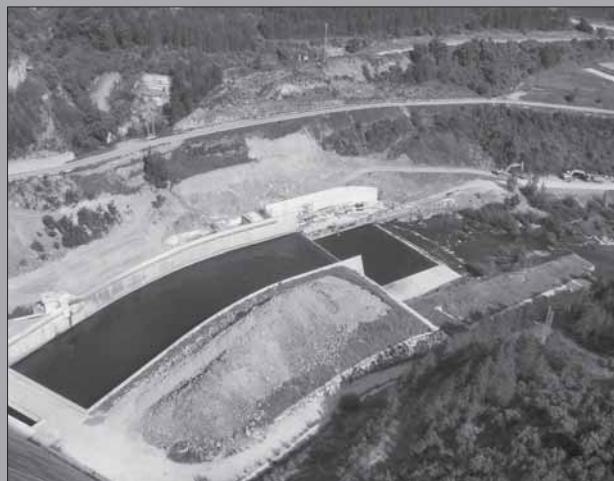
Canal de desagüe. Presa de Itoiz.
