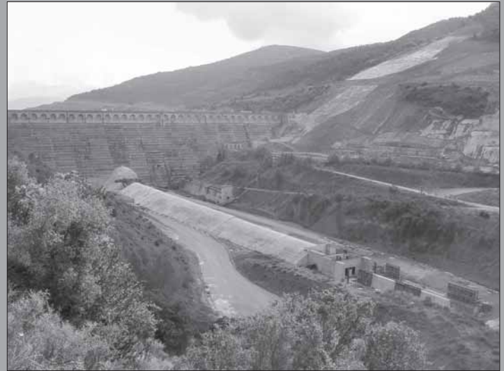
Obras en la presa del embalse de Yesa.
