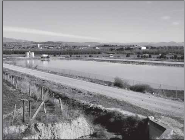
Depuradora de lagunaje en Sangüesa.
