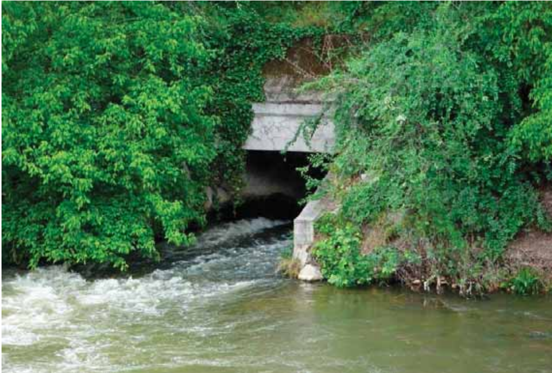
Salida del agua depurada de la EDAR La China.
