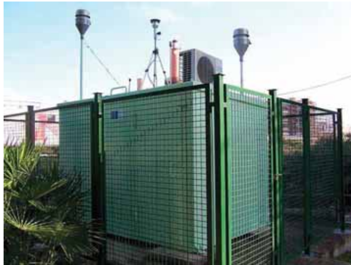
Estación Medidora de Mompeán. Dirección General de Medio Ambiente.
