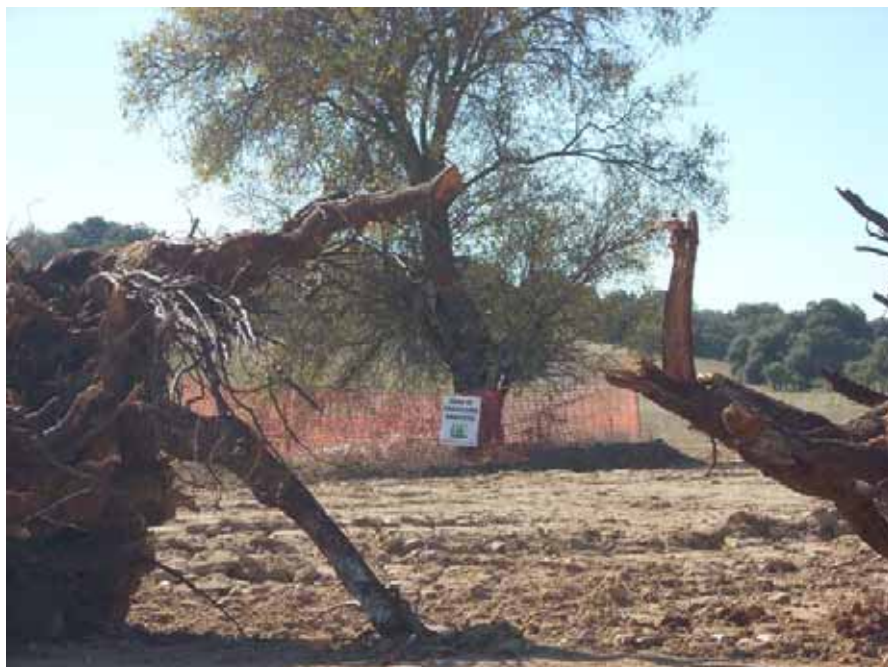
Fotos nº 3 y 4: Desarrollo de las obras del macrovertedero en Dehesa Aceituno (Toledo)
